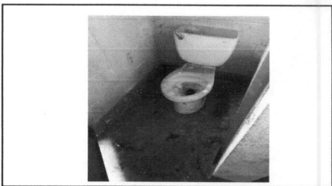
FOTO 10. SUSTITUCION DE INODOROS
