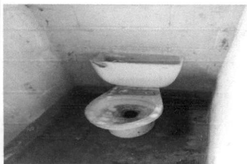
FOTO 5 SUSTITUCION DE PISO.
