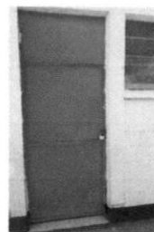
FOTO. SUSUTITUCION DE PUERTA
