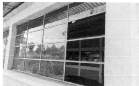
FOTO 4. SUSTITUCION DE VENTANA
